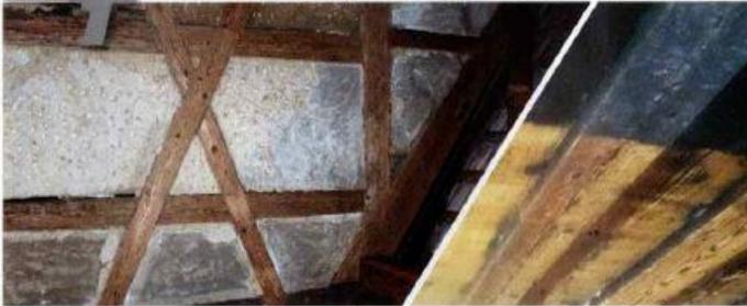
Gerade bei der Sanierung von Holz ist Trockeneis bestens geeignet. Schmutz oder Auftrag wie Farbe oder Lasur, lassen sich bis in die Poren oder Fasern entfernen. Somit bleibt die Struktur erhalten. Anders als beim Schleifen verändert das Trockeneis die Oberfläche nicht.
